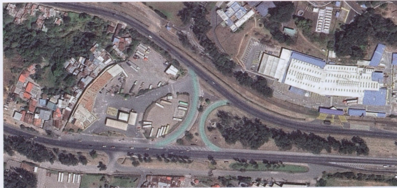
Vista aérea de un retorno en carretera
