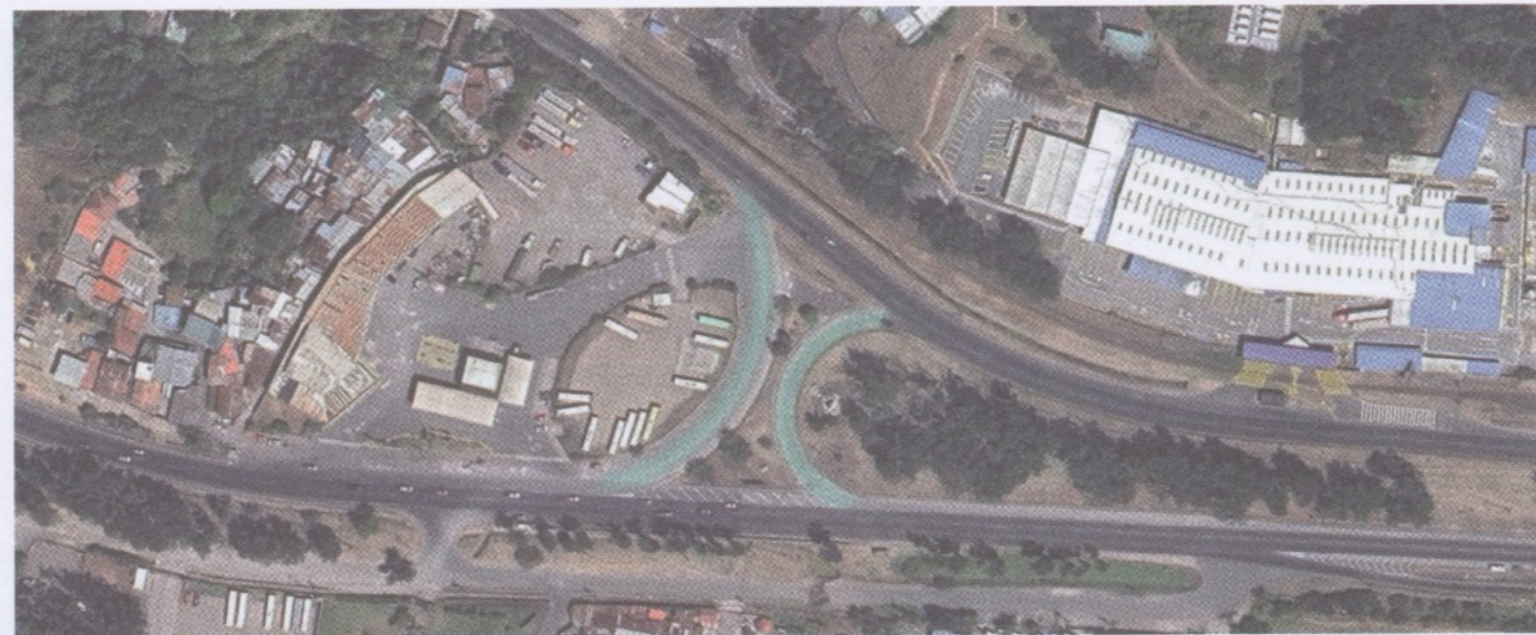
Vista aérea de un retorno en carretera.
